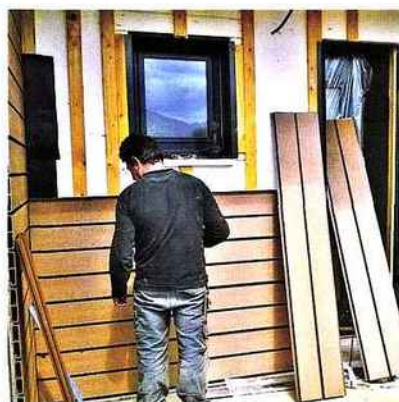
Pose du plafond chauffant et du bardage
