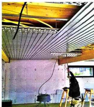
Pose du plafond chauffant et du bardage
